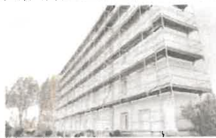
La rénovation déjà bien avancée sur le premier bâtiment doit se poursuivre jusqu'en Juin 2020.
